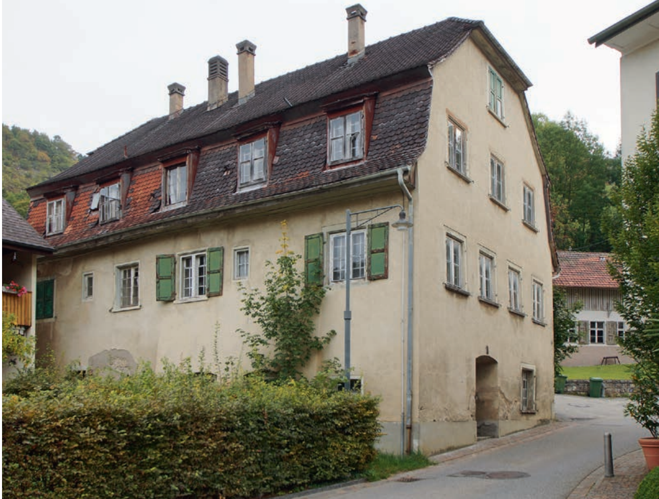
Eptingen, Läuferfingerstrasse 5. Gestalt des Badhauses seit dem Umbau und der Erweiterung des 19. Jahrhunderts.
