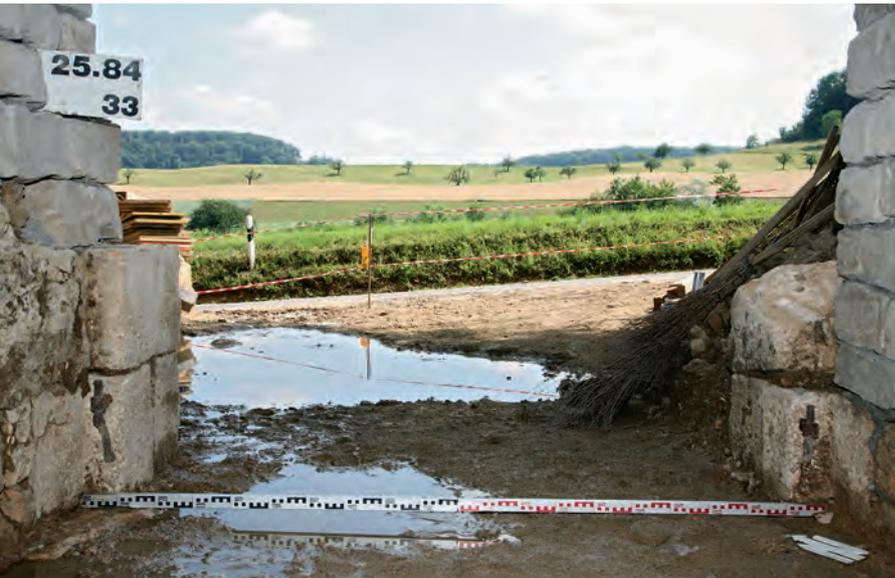
hohen, senkrecht nach oben laufenden Entlüftungsschacht. Dieser war zur Kontrolle der Luftfeuchtigkeit wichtig. Eine zu hohe Feuchtigkeit hätte die Bildung von Schimmel begünstigt. Der Boden war mit Tonplatten bedeckt. Entlang der nordwestlichen Wand verläuft eine Bodenrinne, über die das Schmelzwasser des Eises mit einem Gefälle gegen den Zugangsstollen abgeleitet wurde.
