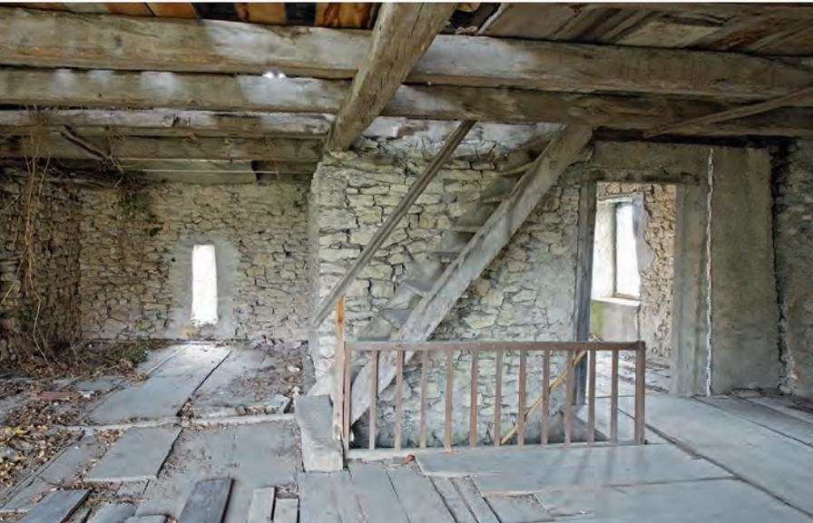
Bald wurde der Schopf an der hangseitigen Mauer im Erdgeschoss mit einer Feuerstelle ausgestattet. Ein Schlot führte in den Dachraum, wo der Rauch frei durch die Dachhaut entwich. Der Zweck dieser ersten Feuerstelle bleibt unbekannt.
