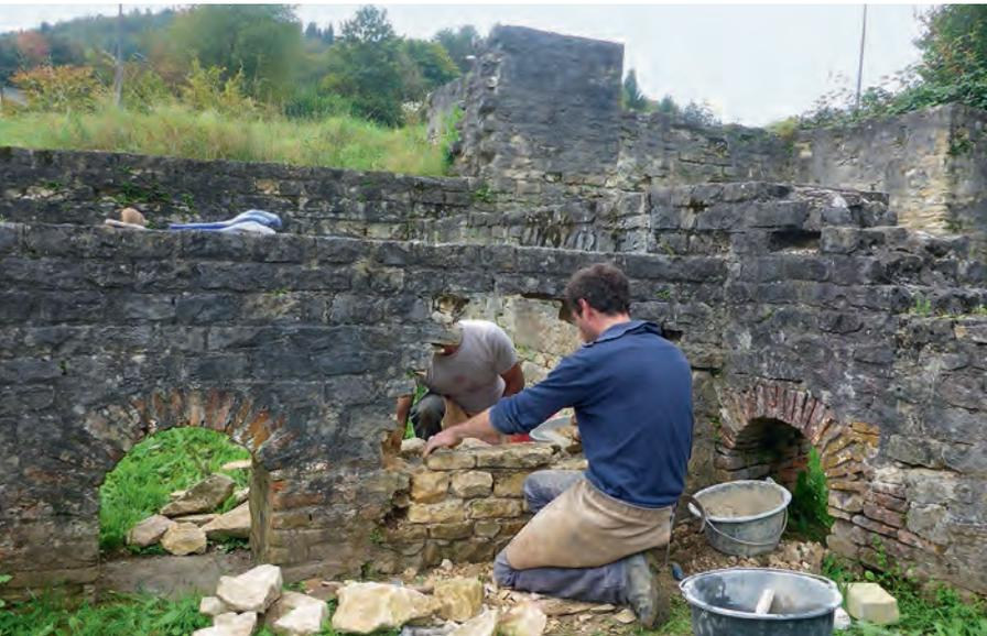
Vor den Sicherungen wurde der gesamte Bestand differenziert nach römischem Originalbestand und rekonstruiertem Mauerwerk aufgenommen. Hilfreich war hierbei, dass man – wie früher vielfach üblich – die Oberkante des originalen Mauerwerks mit Eternitplättchen markiert hatte. Es zeigte sich, dass bei einem heute über dem Bodenniveau sichtbaren Mauerbestand von insgesamt 136 m<sup>3</sup> der Bestand an originaletem antikem Mauerwerk lediglich 36 m<sup>3</sup> beziehungsweise rund 26% umfasst.
