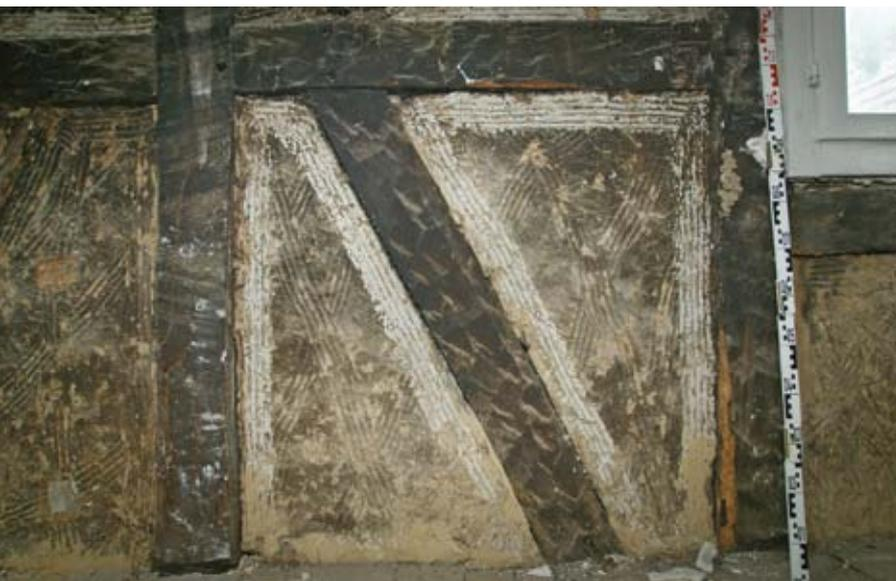
diagonal gerillt. Diese Technik diente entweder einer besseren Haftung des nachfolgenden Deckputzes oder wurde – wie hier im Dachgeschoss – als Wandverzierung offen gezeigt.
