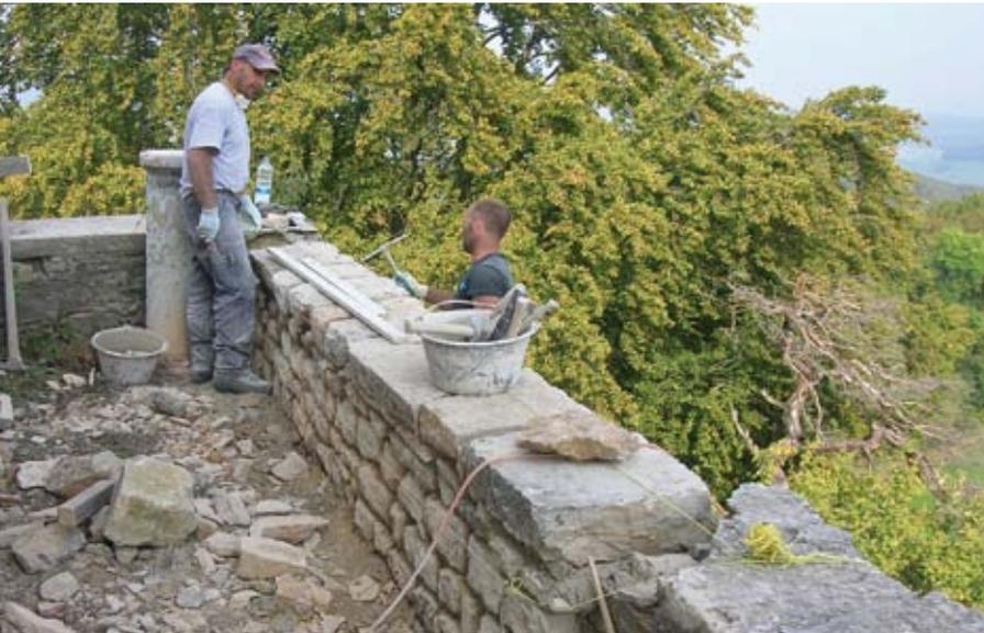
Kalkmörtel überzogen, gefestigt und an mehren Stellen mit Entwässerungslöchern versehen. Danach wurden die anschliessenden, teilweise ebenfalls aufgelösten Mauerkronen auf einer Länge von rund 10 Metern freigelegt, von Baumstrünken befreit und mit einem Mörtelüberzug versehen, dessen Armierung die Mauerschalen zusätzlich verklammert. Das Regenwasser wird nun über zwei kleine Abläufe so abgeleitet, dass es nicht über die Mauer abfliessen und in das Mauerwerk eindringen kann.
