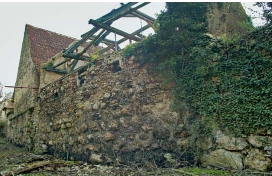
der Leitung der kantonalen Denkmalpflege und des Architekturbüros Schwob & Suter die südliche, bauchende Riegelfassade durch die Firma Gebr. Seckinger AG gesichert und begradigt. Die Nordfassade musste rekonstruiert werden. Der Dachstuhl wurde mit neuen und noch verwendbaren alten Balken
