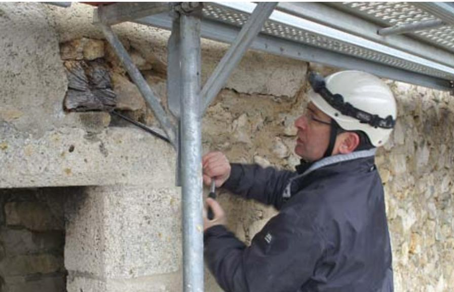
senschale des Mauerwerks miteinander zu verklammern. Da die Auflageflächen der Anker einen möglichst grossen Bereich abdecken sollten, ohne die Mauer selbst zu verdecken, entschloss man sich für spinnenförmige Anker – im Baustellenjargon schnell «Spinnen» genannt. Diese sind auf den Mauerflächen zwar deutlich zu sehen und werden als Konstruktionen für die Sicherheit erkannt, doch beeinträchtigen sie wegen ihrer grazilen Bauart den Gesamteindruck des Bauwerks nicht.
