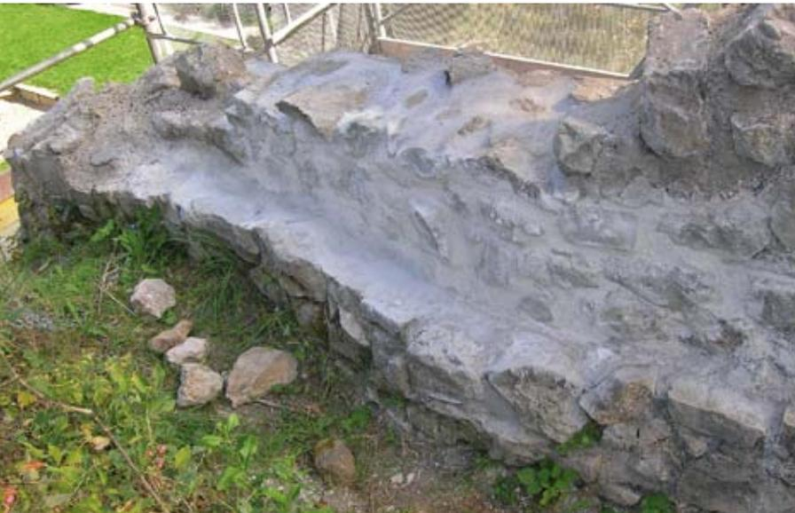
Beratung mit Walter Niederberger von der kantonalen Denkmalpflege sicherte ein hinzugezogener Restaurator diese originalen Reste. An den Fehlstellen wurde nach der Reparatur des Mauerwerks ein neuer Kalkverputz angebracht und farblich dem ursprünglichen Verputz angepasst.
