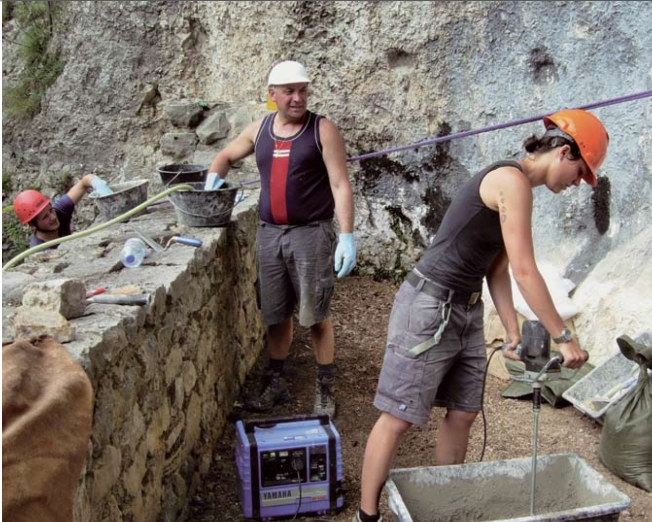
Eptingen, Riedfluh. Johannes Häusermann, Alessandro Mastro- vincenzo und Sarah Hänggi (vlnr) beim Ausflicken von Mauerwerk und Mischen des Spezialmörtels.
