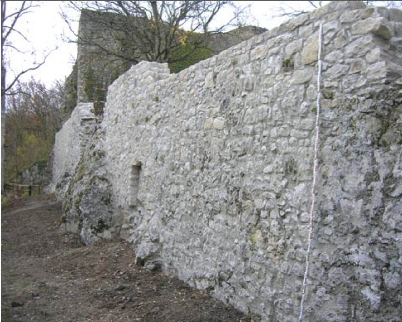
Der fertig sanierte Zwingerbereich.
