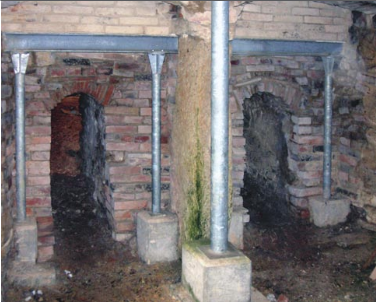
Blick auf die Feuerungöffnung des konservierten Ziegel- ofens.
